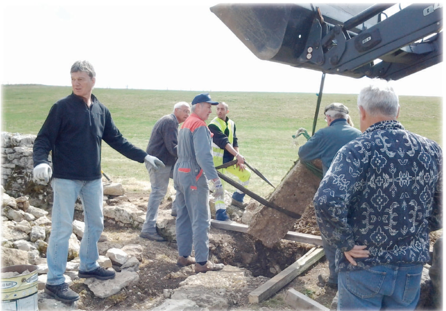
Pose d'une pierre pilier, 14 avril 2017
