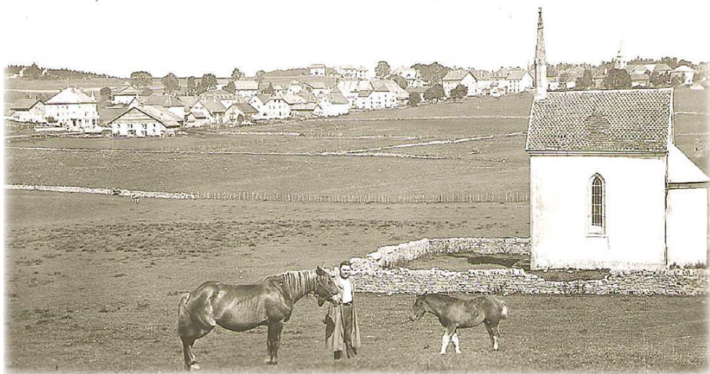
Avant 1960 ce même mur se dégrade déjà partiellement ainsi que la couverture centrale du toit.
