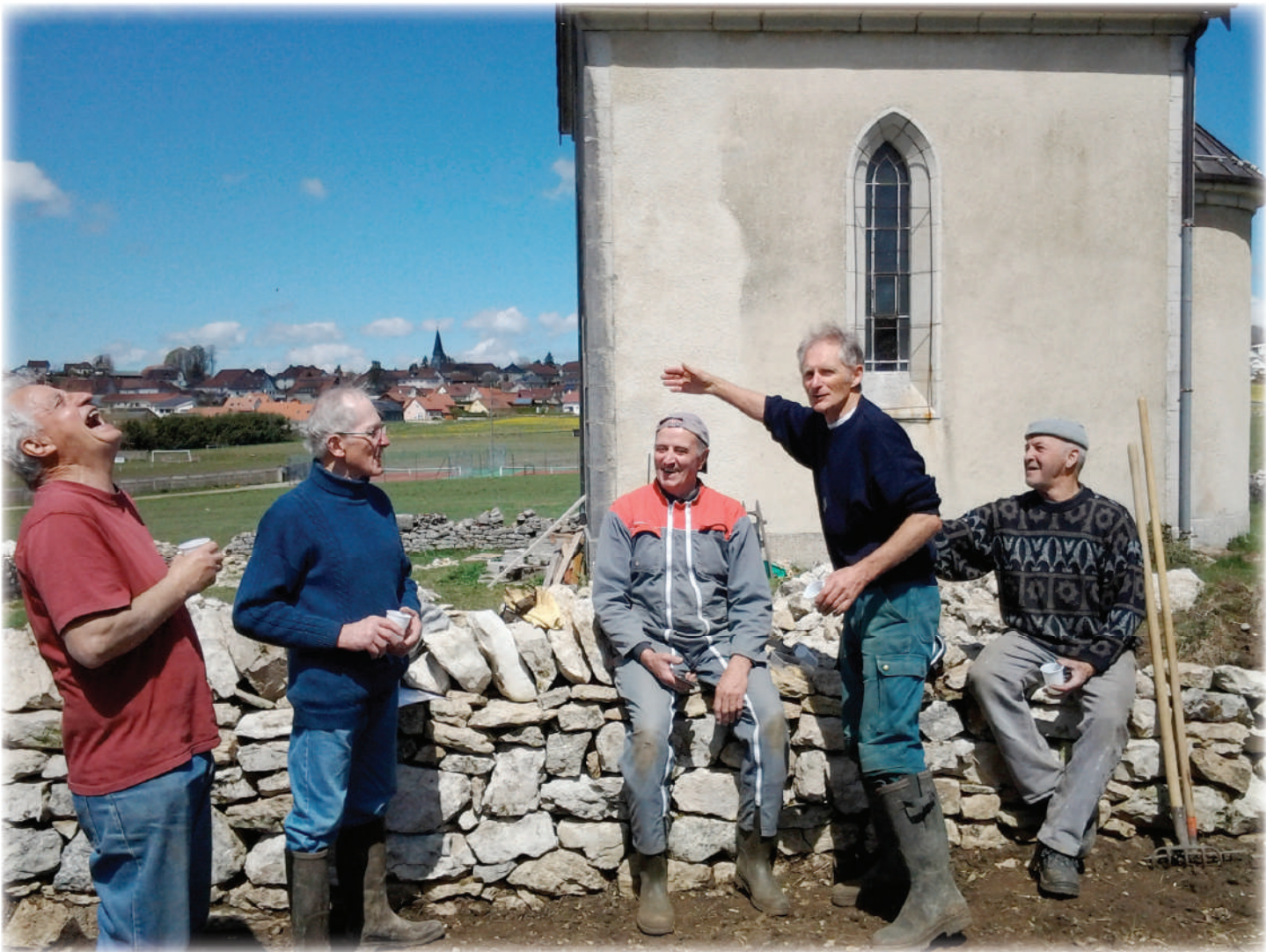
Pose d'une pierre pilier, 14 avril 2017.
