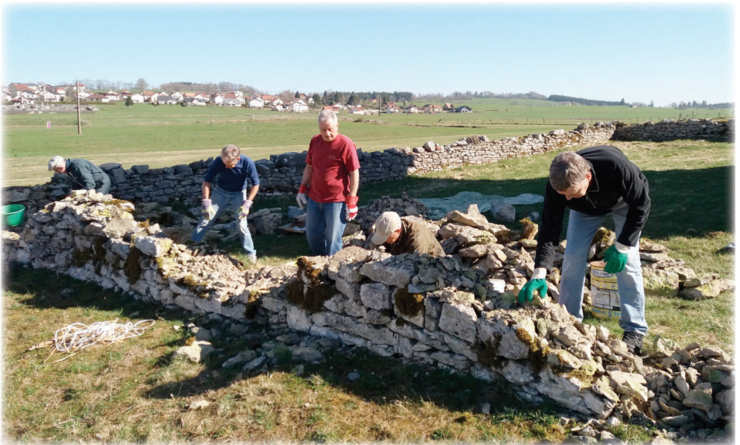
Première phase des travaux, le 8 avril 2017.
